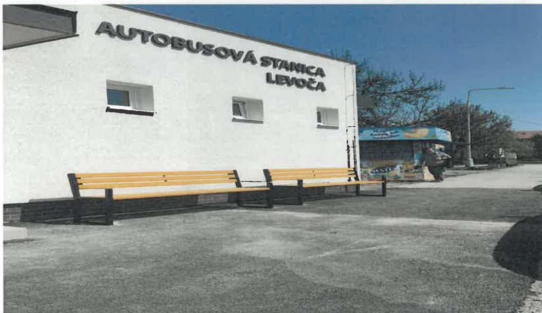
Autobusová stanica Levoča realizovaná 2020
